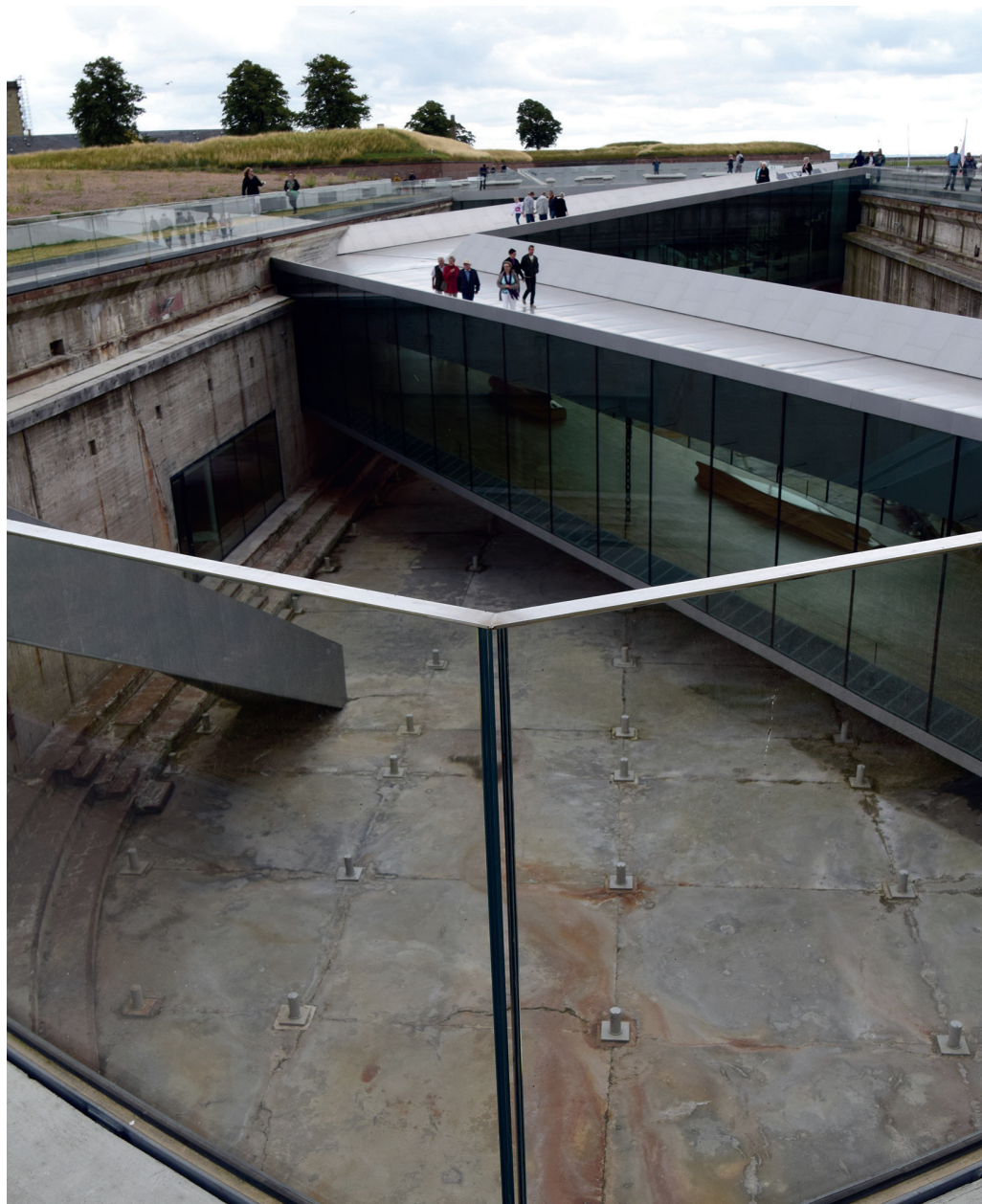
Fig. 1. För att upptäcka museibygnaden måste besökaren gå ända fram till det omgivande räcket av glas. Foto: Annika Bünz, 2015.
